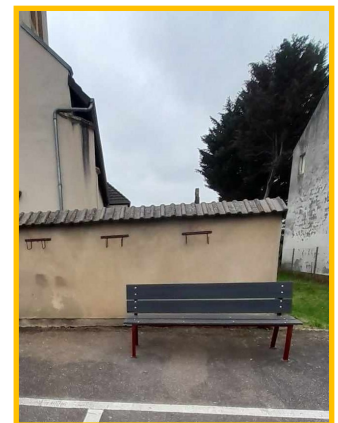
Remise en état du banc
