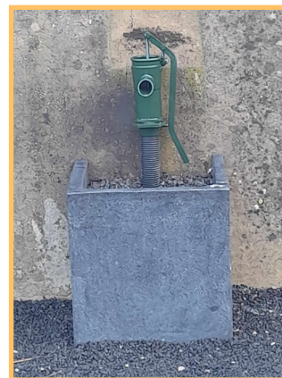
Installation d'une nouvelle pompe à eau au cimetière
